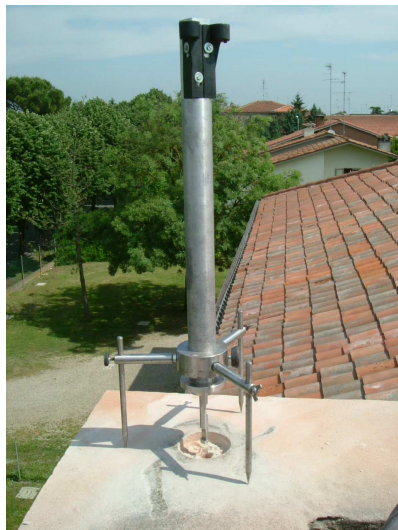
Foto 21 - Sistema di monumentazione per capisaldi 3D Si nota il vertice che sta per essere fondato nella sede predisposta
