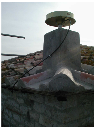
Foto 5 – Antenna GPS ancorata su un pilastrino geodetico costruito su un tetto
