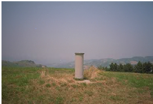
Foto 4 – Pilastrino geodetico
