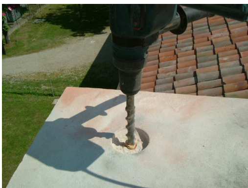
Foto 18 – Si esegue la sede dello stelo del vertice
